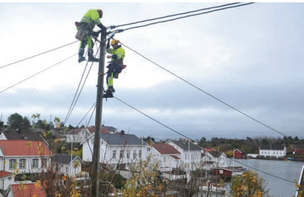
bygging av strømmettet. Her jobber montører i Otera med utbedringer i Lyngør.
